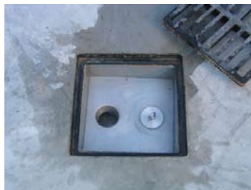
Regard permettant la séparation des eaux pluviales des produits phytosanitaires - Photo IFV, J. Rochard
